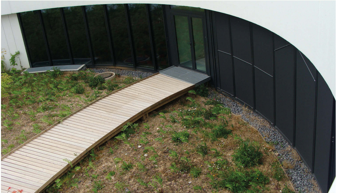
Rampe d'accès à l'amphithéâtre sur l'estrade
