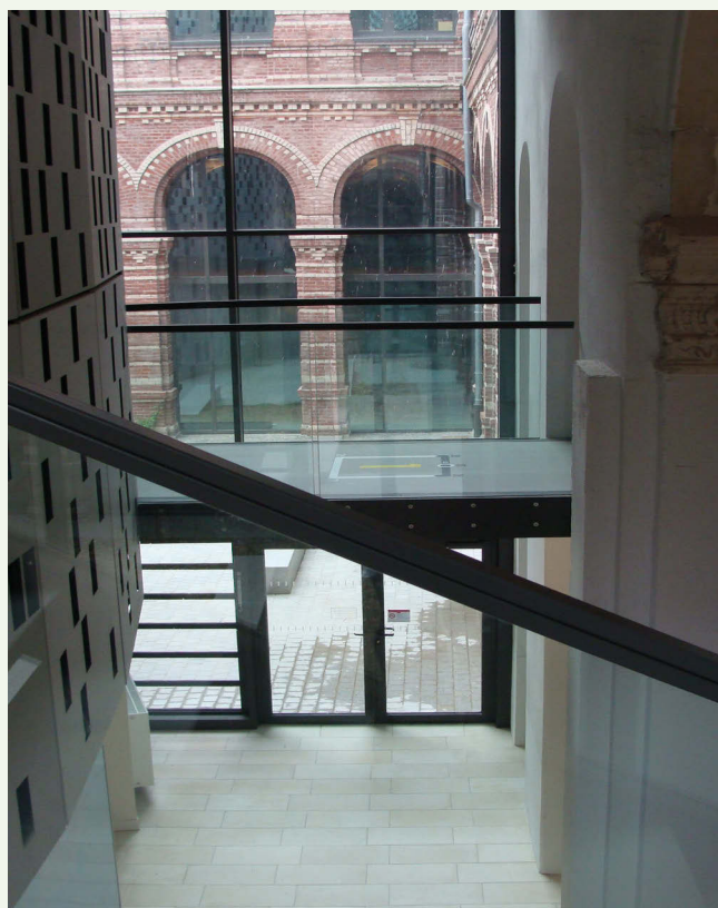
Passerelle aménagée pour l'accès des handicapés moteurs
