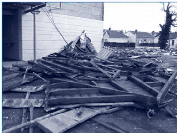
Dégâts de la tempête Klaus au lycée Victor Louis de Talence
