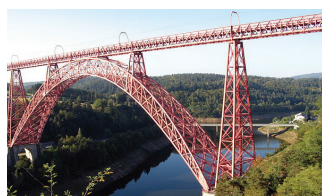
Viaduc de Garabit
